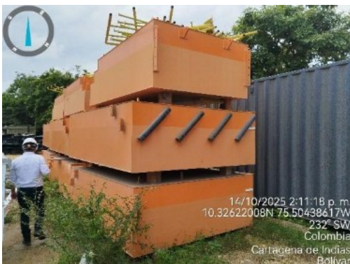
Foto No. 17: módulos apoyados y expuestos sobre la capa vegetal
