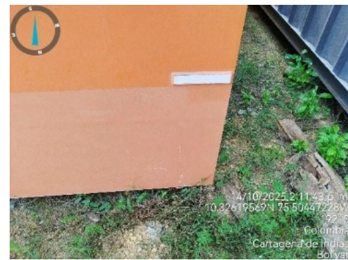
Foto No. 18: módulos apoyados y expuestos sobre la capa vegetal con evidente afectación en pintura (decoloración y tiza).
