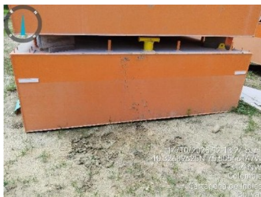
Foto No. 13: módulos expuestos y apoyados sobre suelo natural
