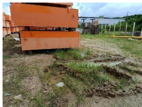
Foto No. 19: Módulos apoyados y expuestos sobre la capa vegetal
